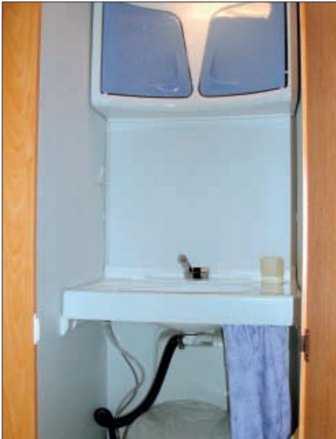
Et gløtt inn i det vesle vaskerommet, med den oppfellbare vaskeservanten.
